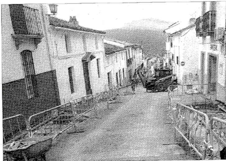
MEJORAS. Obras de accesibilidad y movilidad que se ejecutan en el municipio de Siles.
