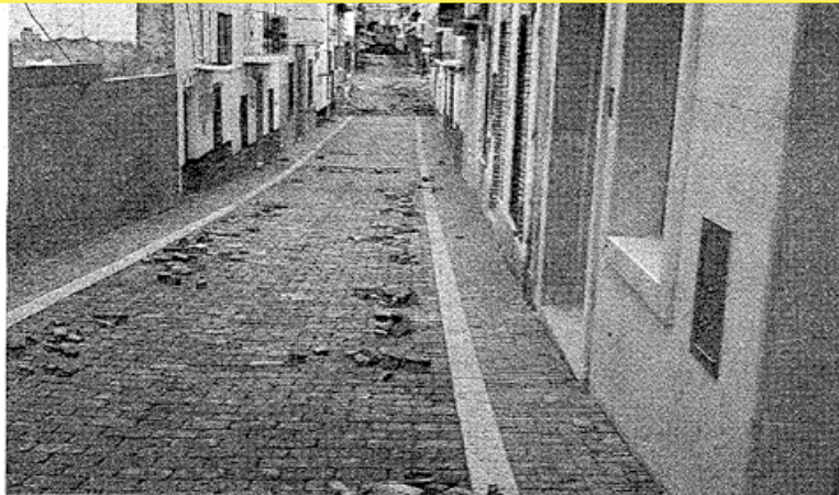
Calle rehabilitada en el casco antiguo de Chilluévar. J.L.L.G.
