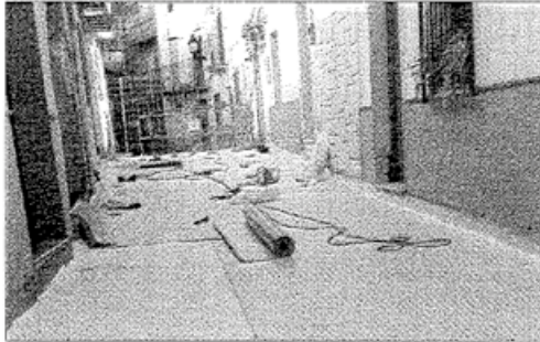
EJECUCIÓN. Obras para evitar humedades en la calle Los Tobazos.
