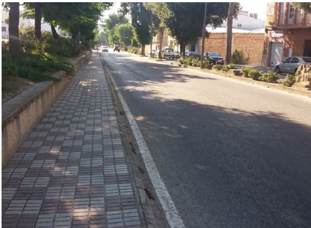
Fotografía 25. Travesía de la carretera A-6175
