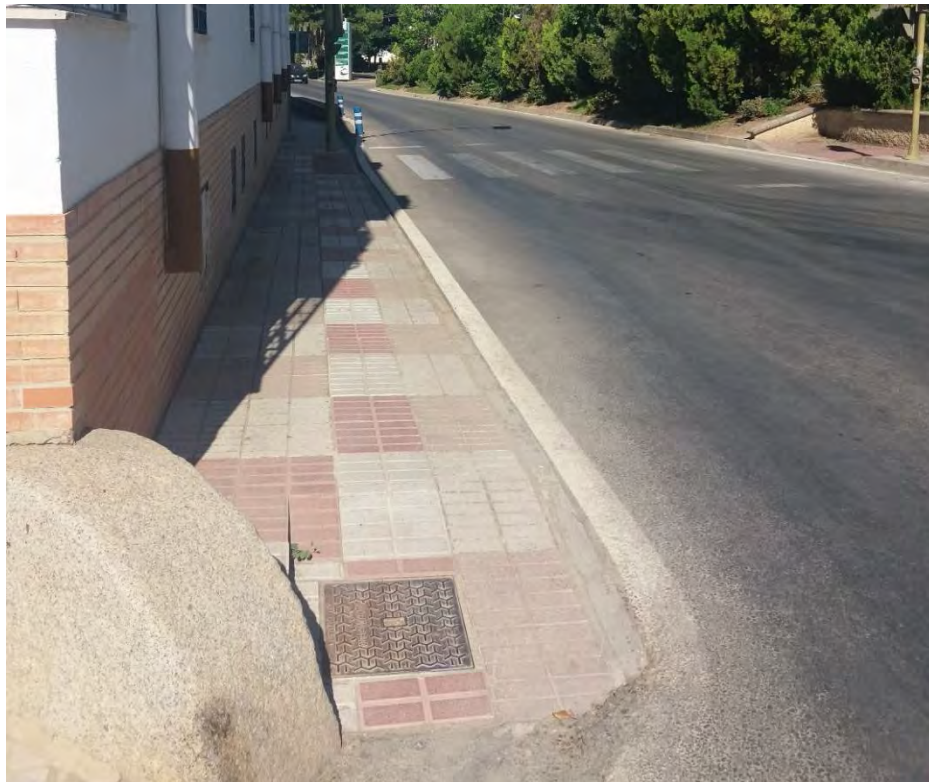
Fotografía 19. Travesía de la carretera A-6175
