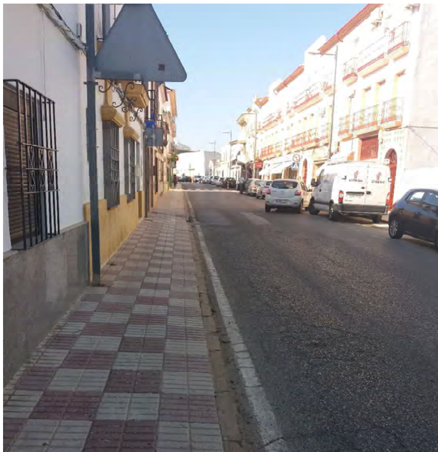
Fotografía 35. Travesía de la Carretera A-6175
