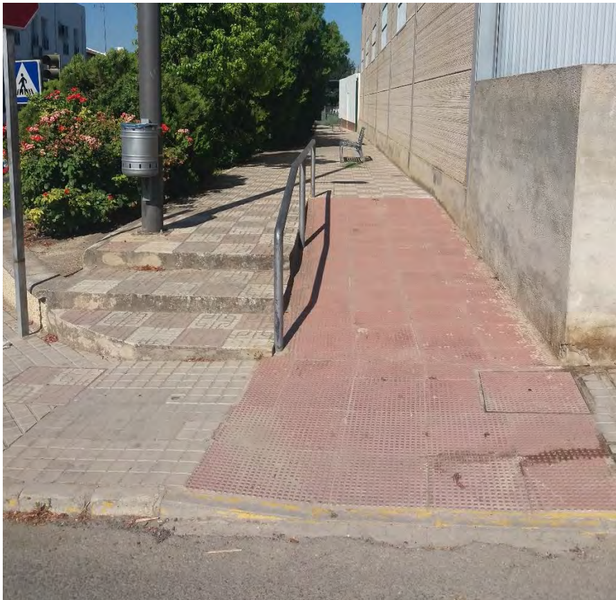
Fotografía 21. Travesía de la carretera A-6175
