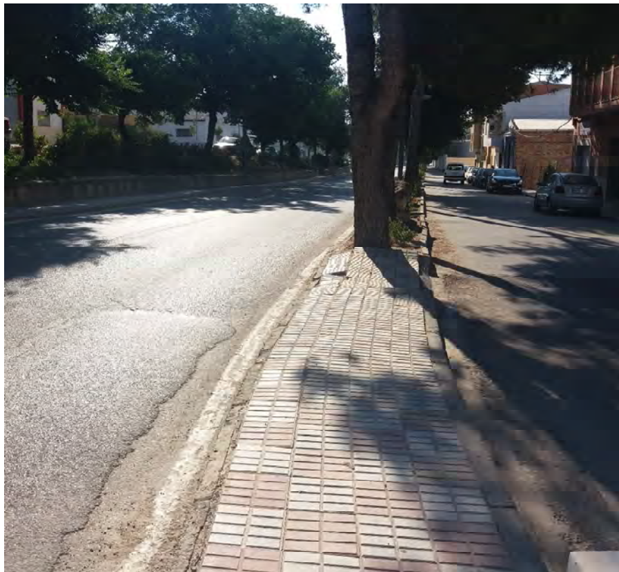
Fotografía 24. Travesía de la carretera A-6175
