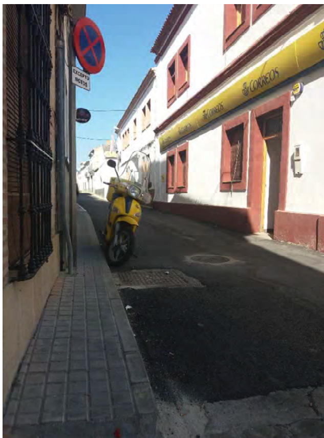
Ilustración 5. Ejemplo de acerado estrecho e inexistente
