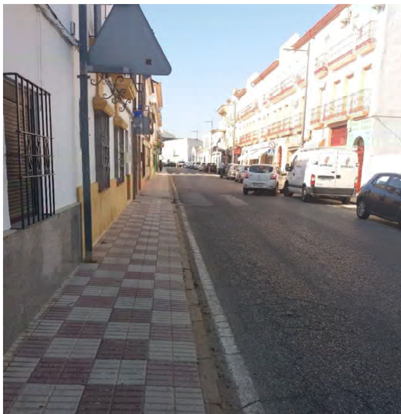
Imagen 4. Ejemplo de falta de elementos reductores de velocidad en la travesía
