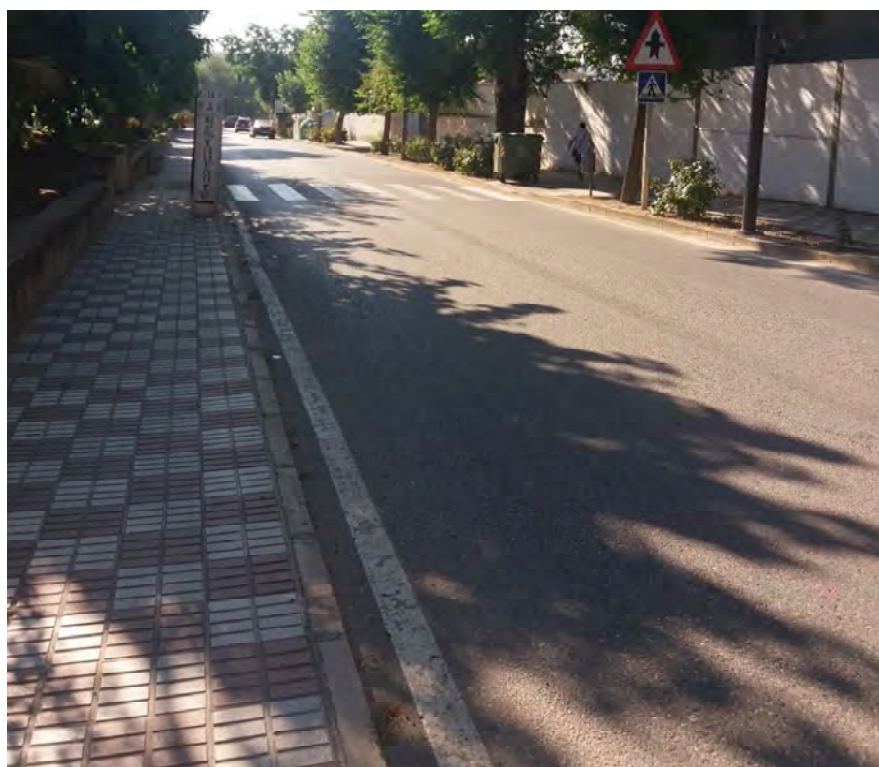
Fotografía 28. Travesía de la carretera A-6175
