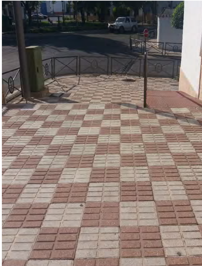
Fotografía 29. Travesía de la carretera A-6175
