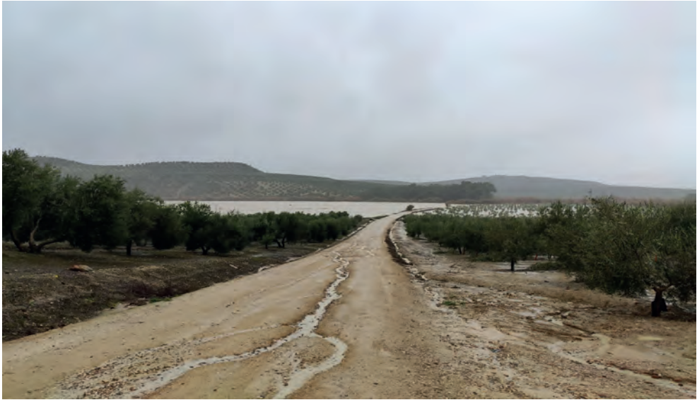
Figura 45. Camino rural no asfaltado que actúa como canal secundario durante los eventos extremos, provocando su rápido deterioro.
