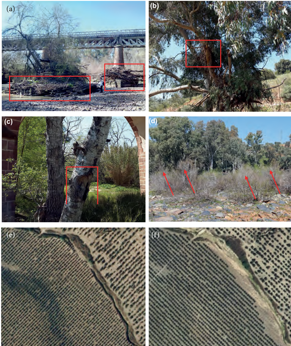
Figura 19. Acumulación de elementos ligeros transportados por el flujo de agua durante la inundación (a-b) sobre vegetación de ribera del río Guadalquivir. (c) Muesca de un ejemplar arbóreo causada por el impacto con un material pesado transportado. (d) Imbricación botánica en el sentido del flujo de inundación de unos ejemplares de Tamarix sp. Cultivo de Olea Europaea en un momento previo (e) y posterior (f) a la inundación relámpago de 2009 en el arroyo de Ibros. Nótese la importante eliminación de ejemplares próximos al cauce.
