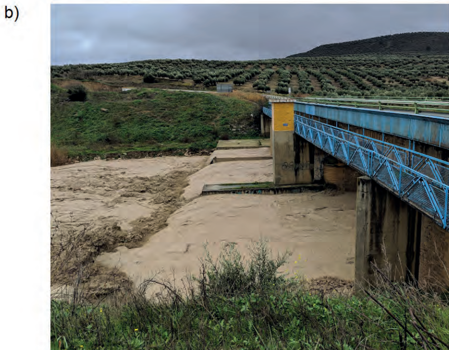
Figura 21. (a) Geometría concreta de la sección del Arroyo Salado de Porcuna donde se ubica la estación de aforo 5142 “Porcuna”. (b) Imagen real de la misma estación de aforo durante la descarga pico ( Q = 219 \text{ m}^3 \cdot \text{s}^{-1} ) de las inundaciones de lluvia corta de diciembre de 2019.
