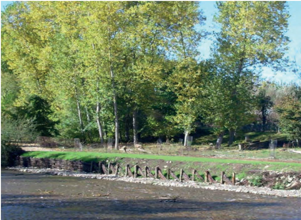
Figura 46. Ejemplo de instalación de fajinas de Pantalla Wolf en el margen de un curso fluvial con el objeto de disminuir la velocidad del flujo y retener material transportado durante la inundación. Fuente: Ministerio de Transición Ecológica (MITECO).
